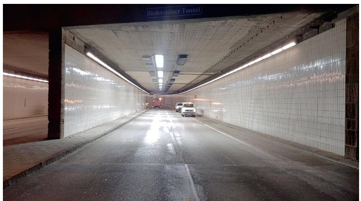
Biedersteini tunnel Münchenis LEDiL-i optikaga Broll System-technik KG valgustitega
